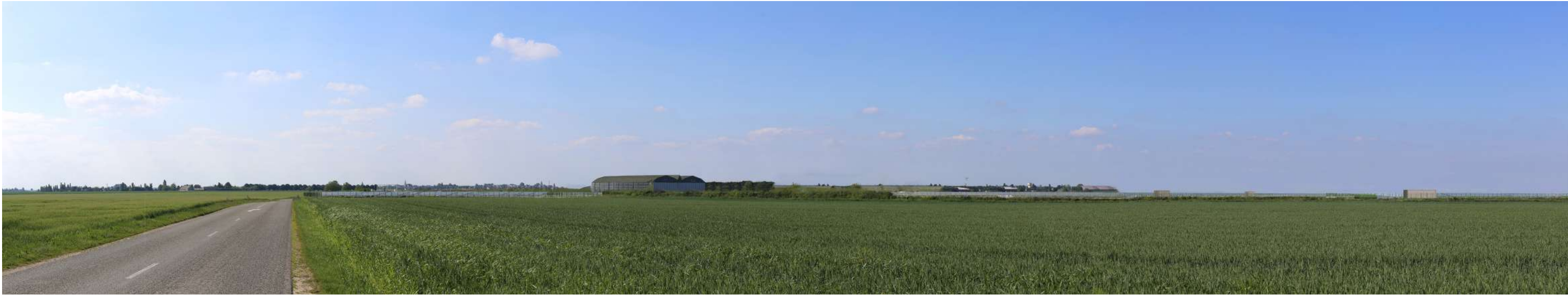
Point de vue n°1 - Vue depuis la route départementale n°31 au sud du projet
